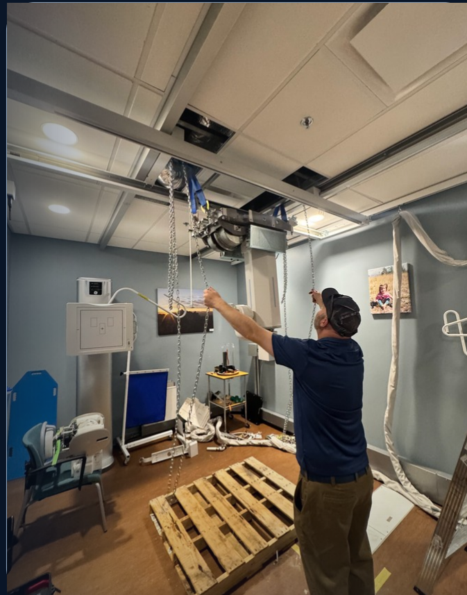
Мониторинг и сервис парка «Электрона» по всей стране
