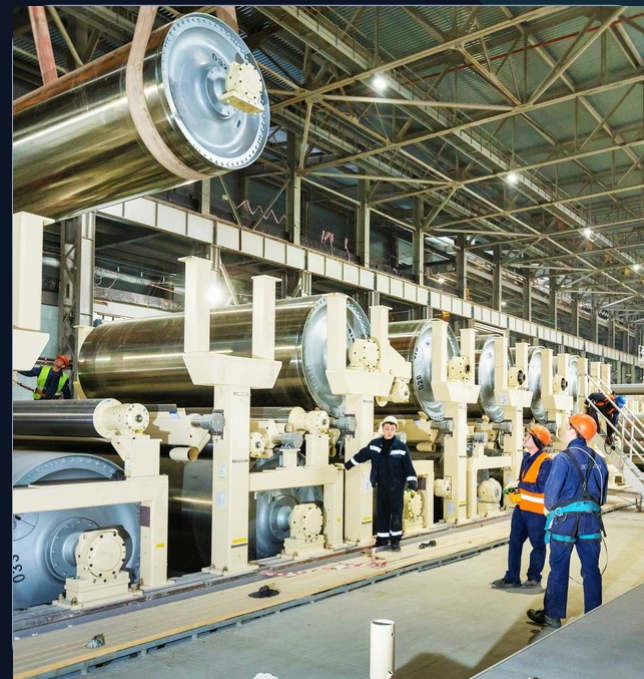
Бумагоделательная машина на монтаже
