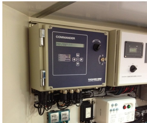
Судовая связь, автоматика и слаботочное оборудование — профиль завода.
